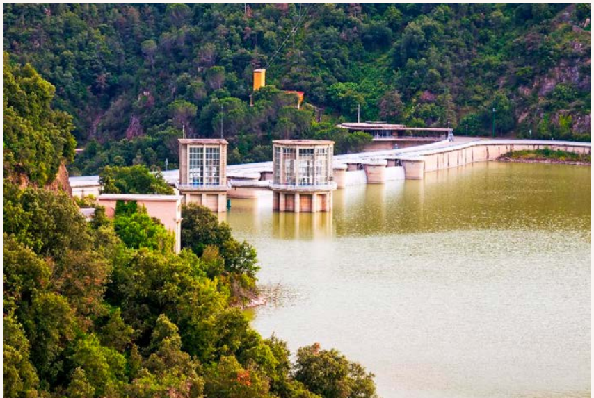
Proyecto Hidroeléctrico Coca Codo Sinclair, el proyecto de infraestructura más grande y costoso en la historia de Ecuador. Financiado por el Export-Import Bank de China y construido por Sinohydro Corporation.
