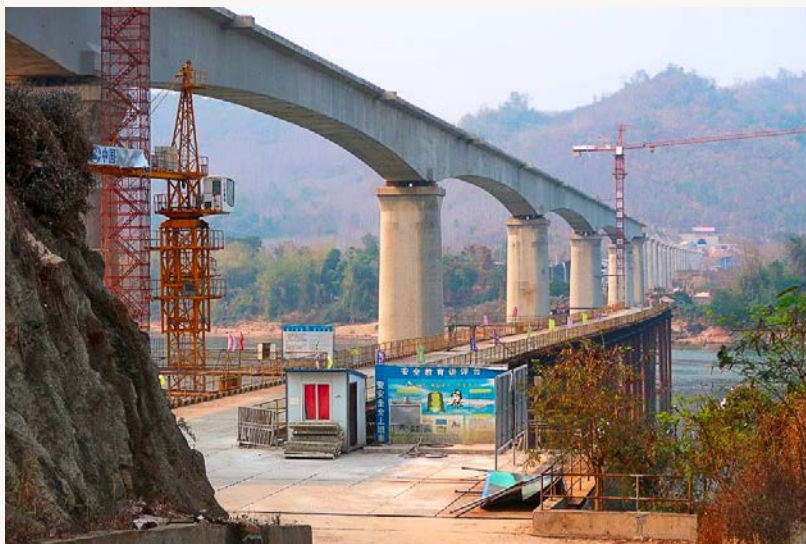
Ferrocarril China-Laos, sitio del proyecto del China Railway No.8 Engineering Group, en la provincia de Luang Prabang, Laos, 2019.
